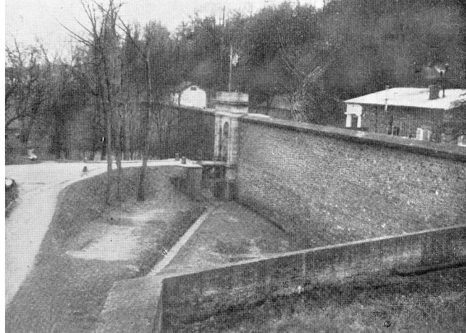
Figure 2 L'entrée du fort. (E. Rousseau; Phot. à Vernon)
